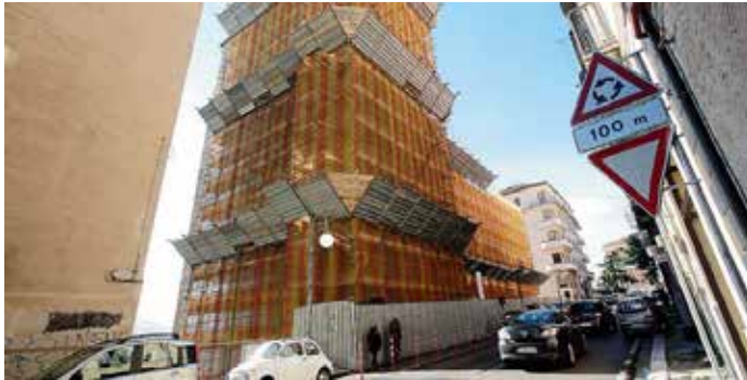
LAVORI L'ex biblioteca provinciale ospiterà la sede dell'Archivio di Stato [foto Tony Vecce]
