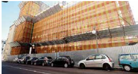
IMPALCATURA I lavori a rilento per problemi giudiziari e burocratici [foto Tony Vecce]
