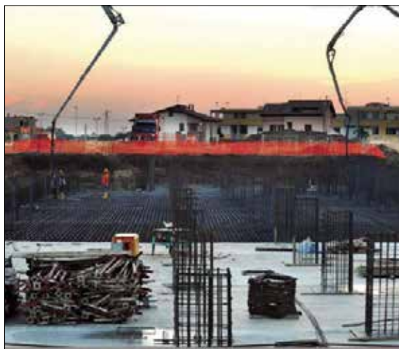
Il cantiere della nuova scuola di Scanzano Jonico
