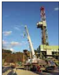
Un pozzo in fase di scavo nell'area del centro oli Tempa Rossa in costruzione
