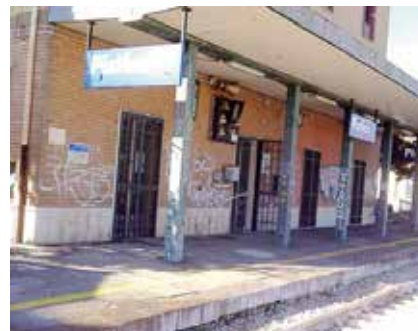
LA STAZIONE In balia dell'incuria e dei vandali [foto Miolla]
