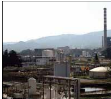
L'impianto di Tecnoparco Valbasento
