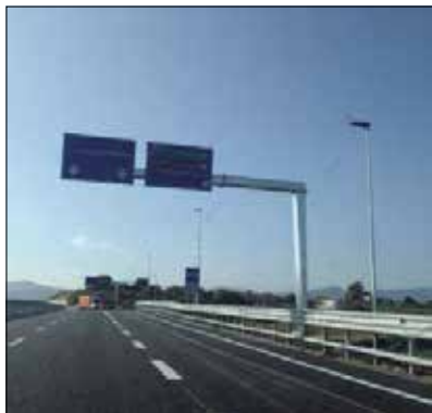
Lo svincolo Sud sulla nuova Ss 106 a Nova Siri
