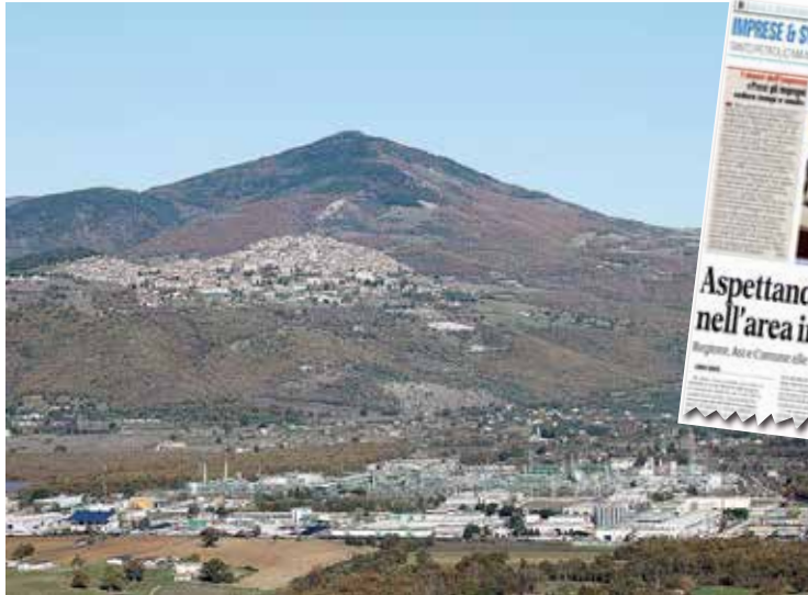
VIGGIANO L'area industriale dell'Alta Val d'Agri dove sono in corso interventi di completamento infrastrutturale su strade, reti gas, acqua, adsl. In alto, la Gazzetta del 2 ottobre scorso in cui Regione, Asi e Comune si impegnavano a rendere entro marzo la più efficiente della Regione [foto Tony Vecce]
