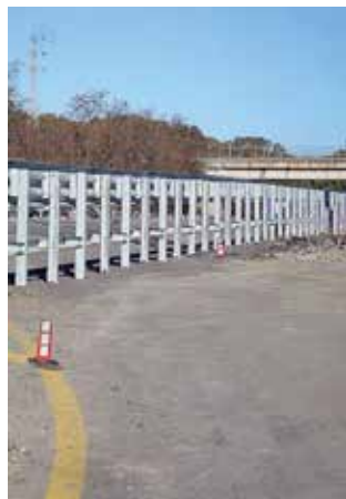
VIABILITÀ Il tratto da sistemare [foto Mele]
