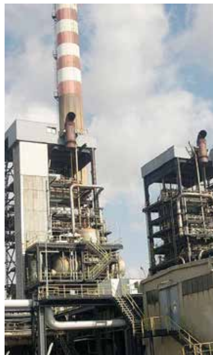
INDUSTRIA Una fabbrica della Valbasento
