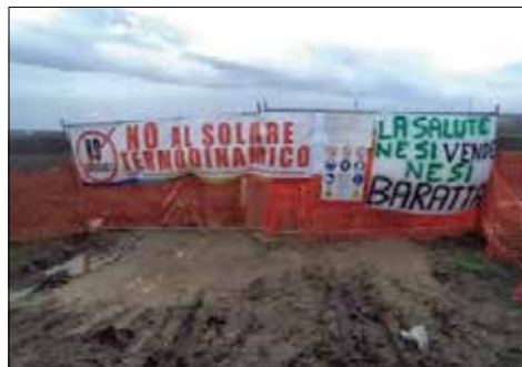
L'area del cantiere dove sorgerà la centrale termoelettrica
