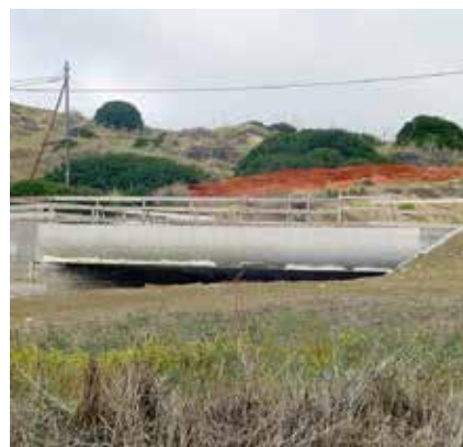
I LAVORI Un ponte in costruzione della Bradanica
