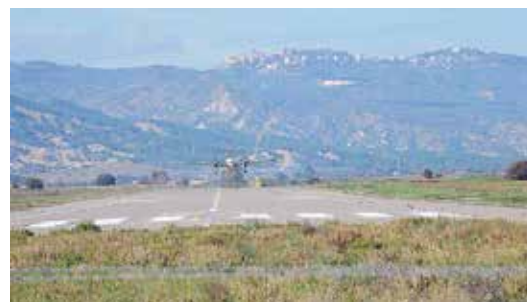
ASFALTO Un dettaglio della pista Mattei di Pisticci scalo
