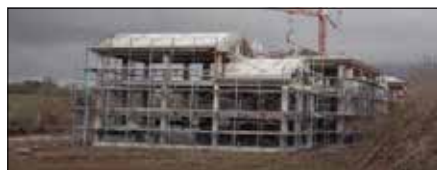
Sopra la scuola Nitti, sotto il cantiere di contrada Bicocca
