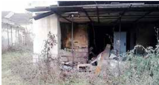
EX AUTOPARCO Il capannone in viale del Basento
