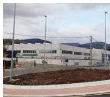
STABILIMENTO La fabbrica della San Benedetto
