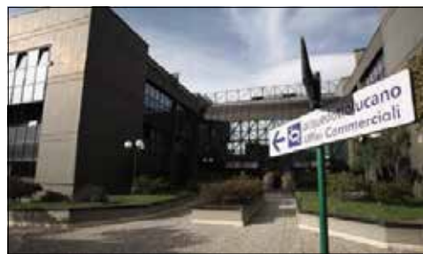
La sede di Acquedotto lucano di via Grippo a Potenza
