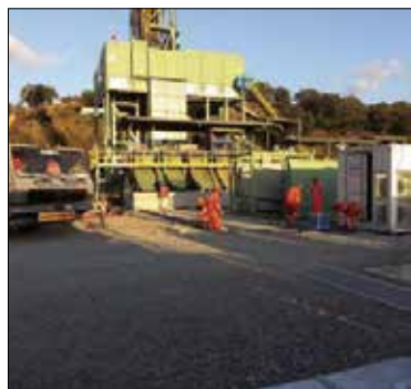
Un pozzo in fase di scavo nei pressi del Centro oli Tempa Rossa a Corleto
