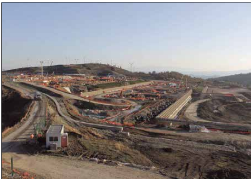
Il Centro oli di Tempa Rossa in fase di costruzione
