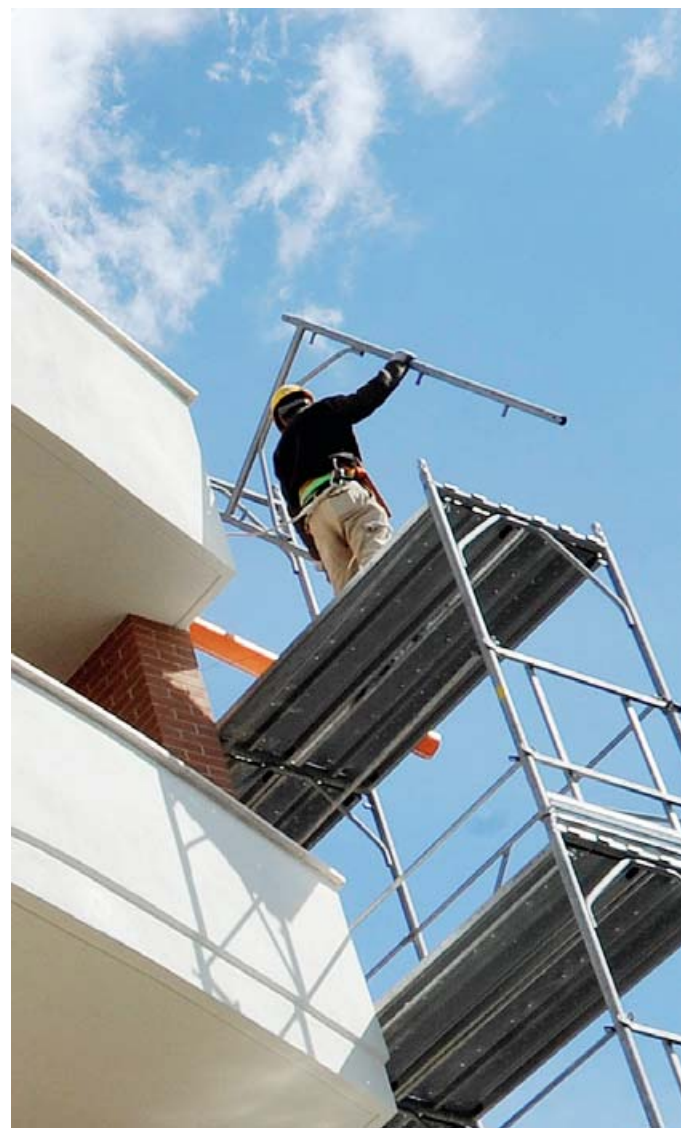
CANTIERI Denunciato il lavoro nero anche nel settore dell'edilizia
