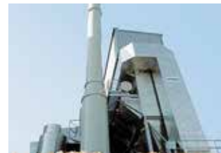
BIOMASSE Nella foto d'archivio una centrale
