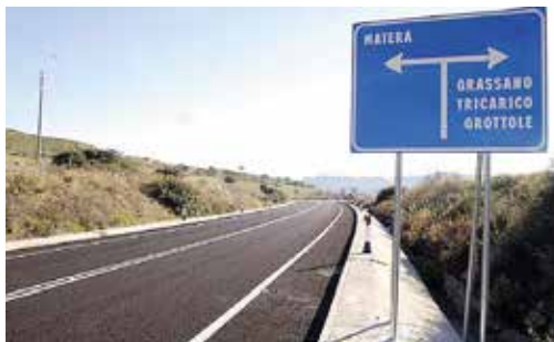
STORIA INFINITA Lo svincolo per la Bradonica sulla provinciale per Matera
