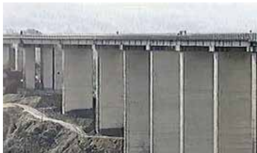
VIADOTTO ITALIA Il ponte sull'A3, il più alto dell'intera nazione, tra Lagonegro e Laino dove è successo l'incidente che è costato la vita all'operaio rumeno
