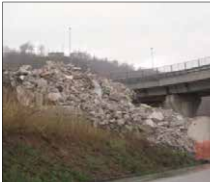
Le macerie dopo la demolizione
