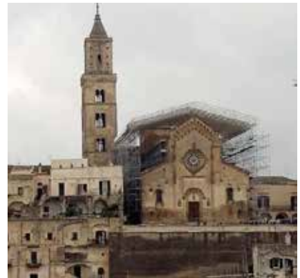
CATTEDRALE Evidenti i lavori in corso sul tetto
