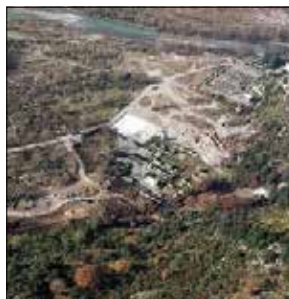
Il depuratore di San Sago
