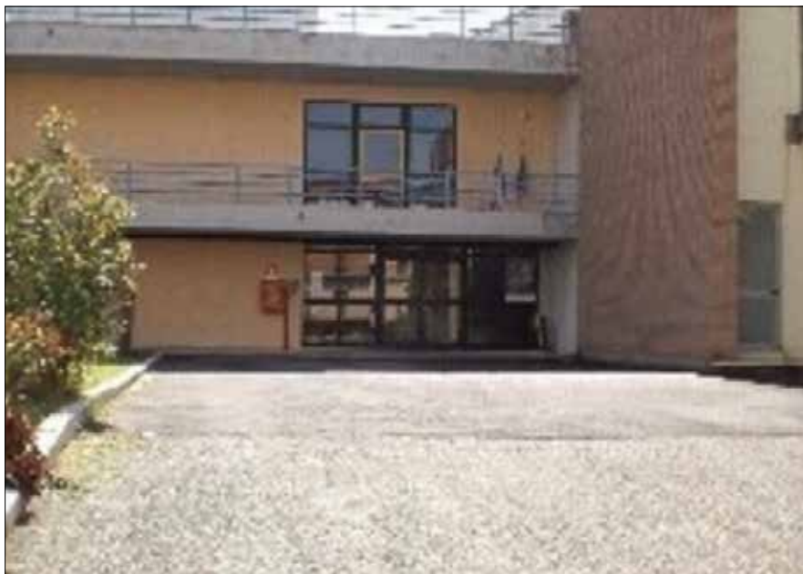
L'ingresso dell'Istituto comprensivo di Atella.
