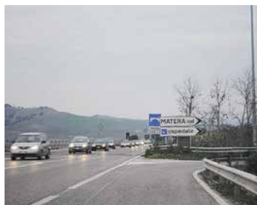
VIABILITÀ La strada statale 7 Matera - Ferrandina [foto Genovese]
