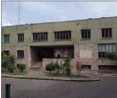
La sede materana del Consorzio di bonifica
