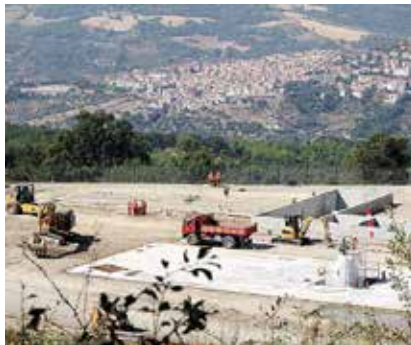
CANTIERE I lavori al centro oli di Tempa Rossa [foto Tony Vecè]
