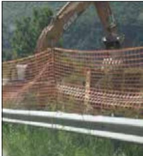
Alcune immagini del cantiere
