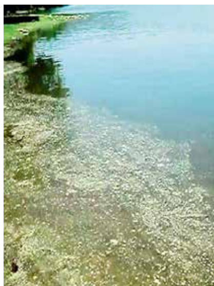
ACQUA Un particolare della diga del Pertusillo (foto Tony Vecce)
