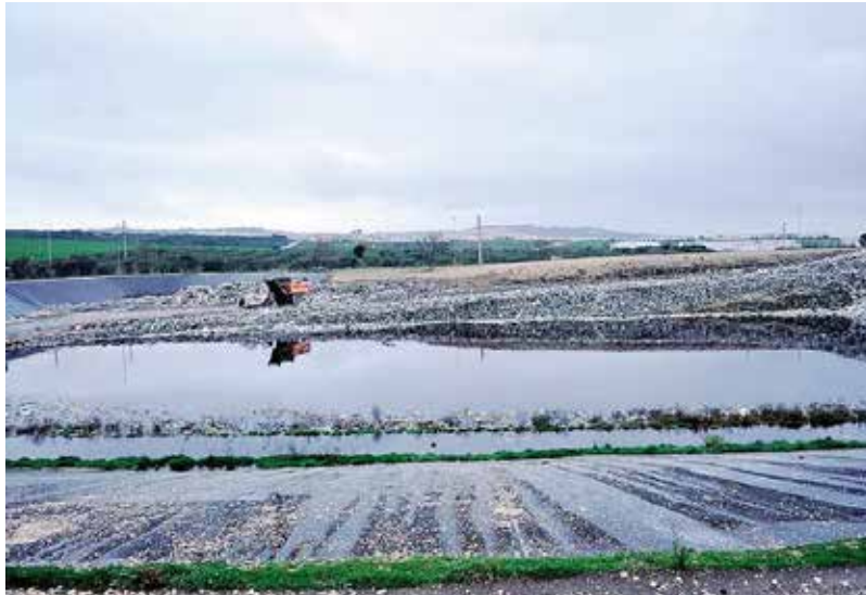
SMALTIMENTO L'impianto per il trattamento dei rifiuti a La Martella [foto Genovese]
