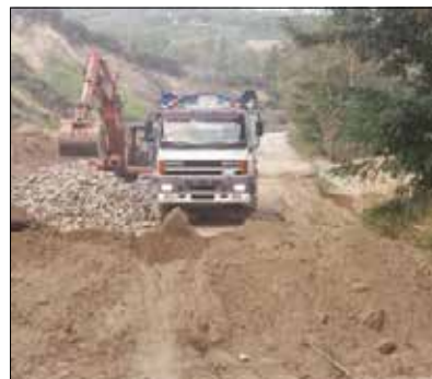
Cantiere su di una strada di Marconia
