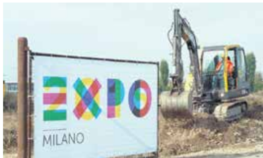
un cantiere dell'Expo di Milano FOTO INFOFOTO
