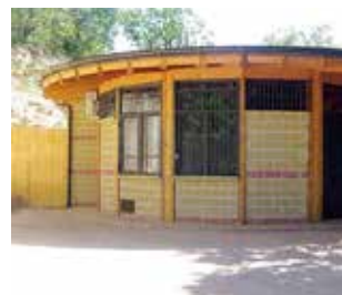
STRUTTURA Il parco Elisa Claps [foto Tony Vecce]
