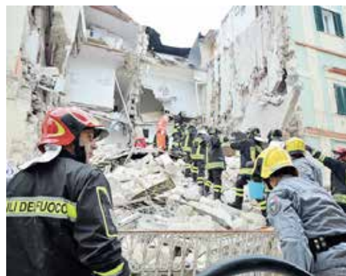
CINQUE MESI FA Le due palazzine di vico Pieve dopo il crollo [foto Genovesi]
