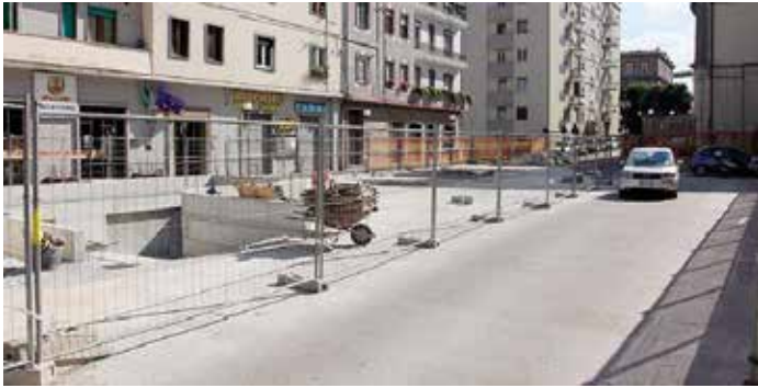
OPERA Ecco come si presenta oggi piazza Bonaventura [foto Tony Vecce]
