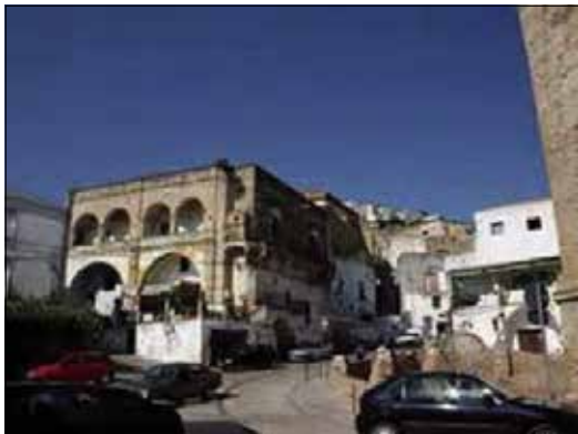
Pomarico. La palestra è ancora incompleta dopo il fallimento dell'impresa costruttrice
