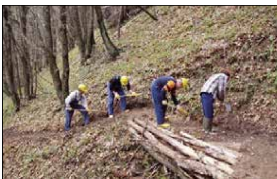
Operai forestali al lavoro
