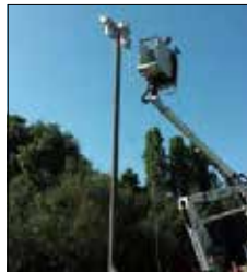
I lavori all'illuminazione di Policoro
