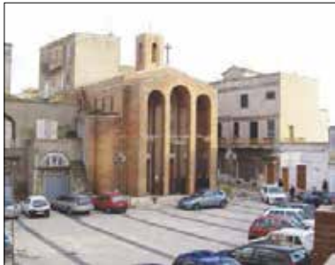
La chiesa di San Rocco oggi chiusa al culto
