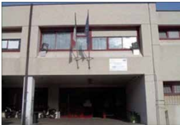
L'ingresso dell'Istituto tecnico per Geometri Olivetti che rischia di perdere il proprio indirizzo in Costruzioni, ambiente e territorio
