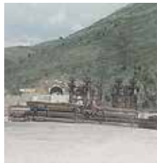
GALLERIA Il cantiere dell'incidente
