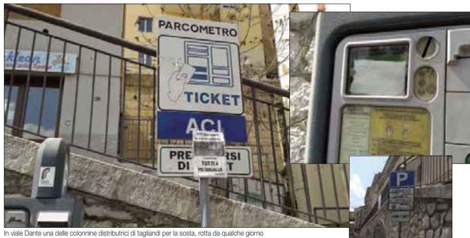
In viale Dante una delle colonnine distributrici di tagliandi per la sosta, rotta da qualche giorno
