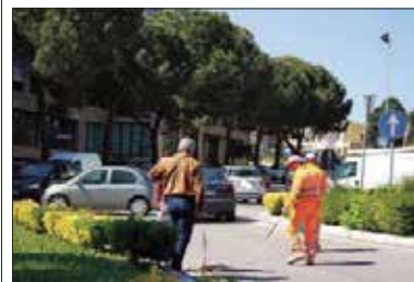
La rotatoria del Pino i cui lavori proseguono a grandi passi
