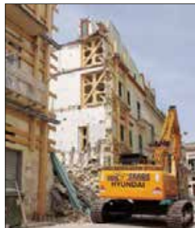
La messa in sicurezza di vico Piave
