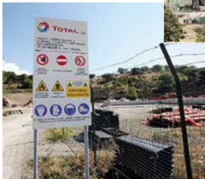
CANTIERE Procedono i lavori a Tempa Rossa
