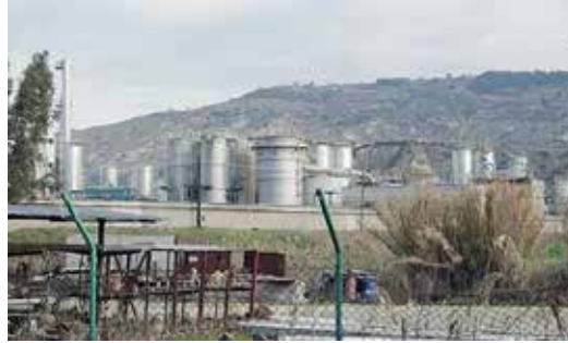
INCOMBE UN RISCHIO Gli impianti della Mythen a Ferrandina. Un silos di liquido pericoloso minaccia di cedere
