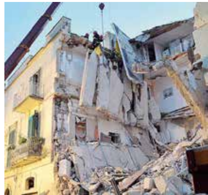
MESSA IN SICUREZZA I vigili del fuoco al lavoro [foto Genovese]
