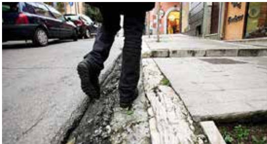
CAMMINAMENTI PEDONALI Il marciapiede di via Caporelli [foto Toni Vece]
