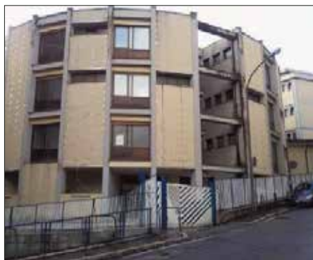
La sede Asp di via Torraca. A sinistra il cartellone di inizio lavori
