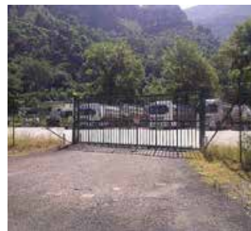
CANCELLI L'ingresso del depuratore per rifiuti speciali che si trova fra Trecchina e Tortora
