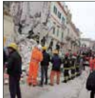
Il crollo di vico Piave
