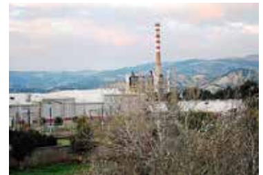
VALBASENTO L'area industriale di Pisticci [foto Grieco]
