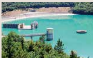
INVASO La diga della Camastra [foto Tony Vecce]
