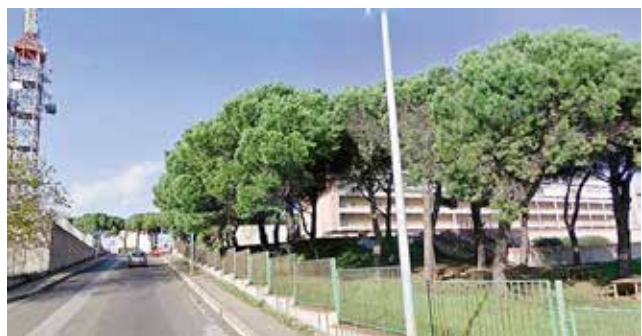
LO STUDENTATO Visto attraverso gli alberi da via Annibale Maria di Francia prima dell'inizio dei lavori
