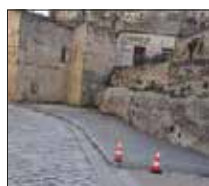
La colata di cemento nei Sassi
