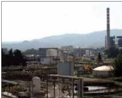
Una vasca ancora scoperta nell'impianto di Tecnoparco Valbasento a Pisticci Scalo
