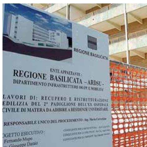
PADIGLIONE STELLA Lo studentato, uno scorcio del cantiere fermo
