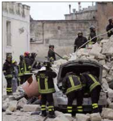
Il crollo di vico Piave dell'11 gennaio scorso
