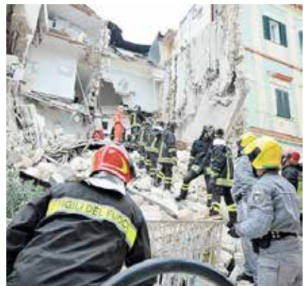
DISASTRO I soccorritori al lavoro in vico Piave [foto Genovese]
