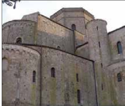
La monumentale Cattedrale di Acerenza, ancora oggi fonte di studio e ammirazione
