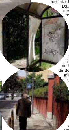
Il tratto di strada davanti alla sede di un notaio in pessime condizioni
