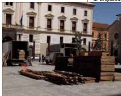
I lavori in piazza per l'allestimento
