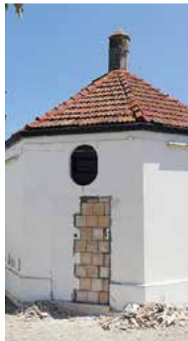
RICOSTRUITO Il chiosco con l'ingresso murato
