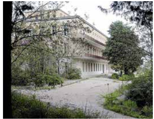
EX OSPEDALE L'area interessata ai lavori per il campus, nel rione Lanera [foto Genovesi]
