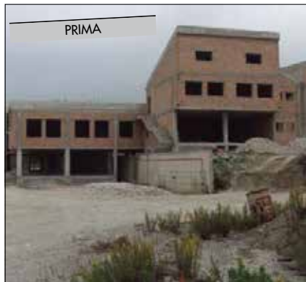
La struttura grezza, circa sei anni fa. Accanto la struttura com'è oggi
