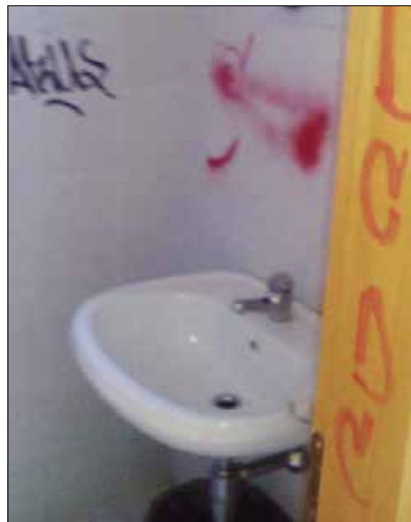
I bagni imbrattati al parco di Montereale, di fronte alla piscina comunale 37 dei quali, su 81, sono stati licenziati.
