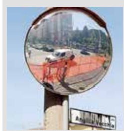
SOTTOPASSO Al via i lavori
