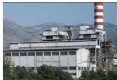
La centrale del Mercure
