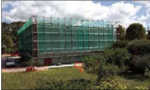
I lavori alla scuola e una veduta Rivello
