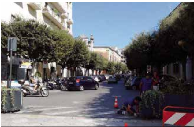
Gli operai di Verdemania di Poggiorsini al lavoro per montare le fioriere elettroniche
